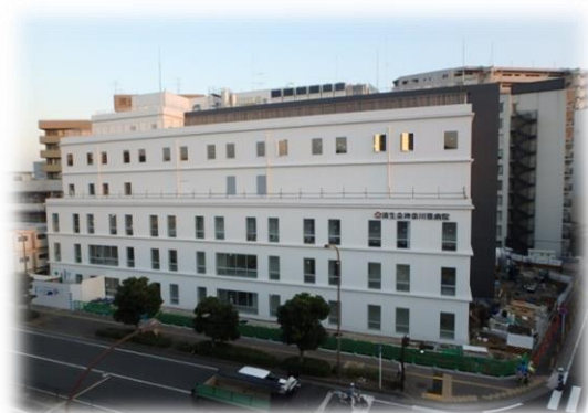
現在の新棟（建設中）
